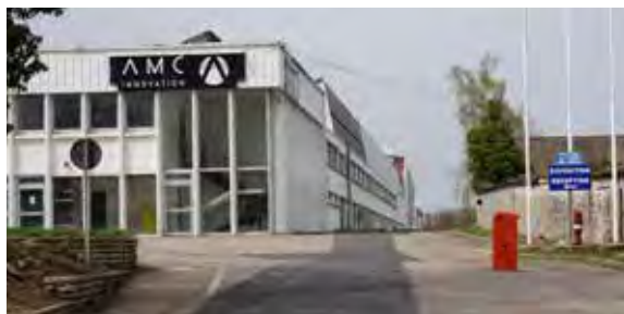
→ Locaux AMC à Jarville-la-Malgrange
